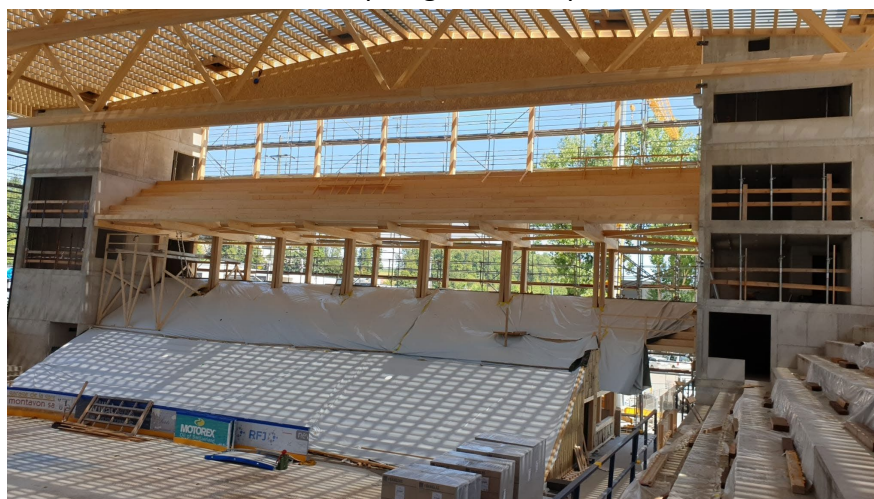
Façade Est et protection de la toiture en bois
